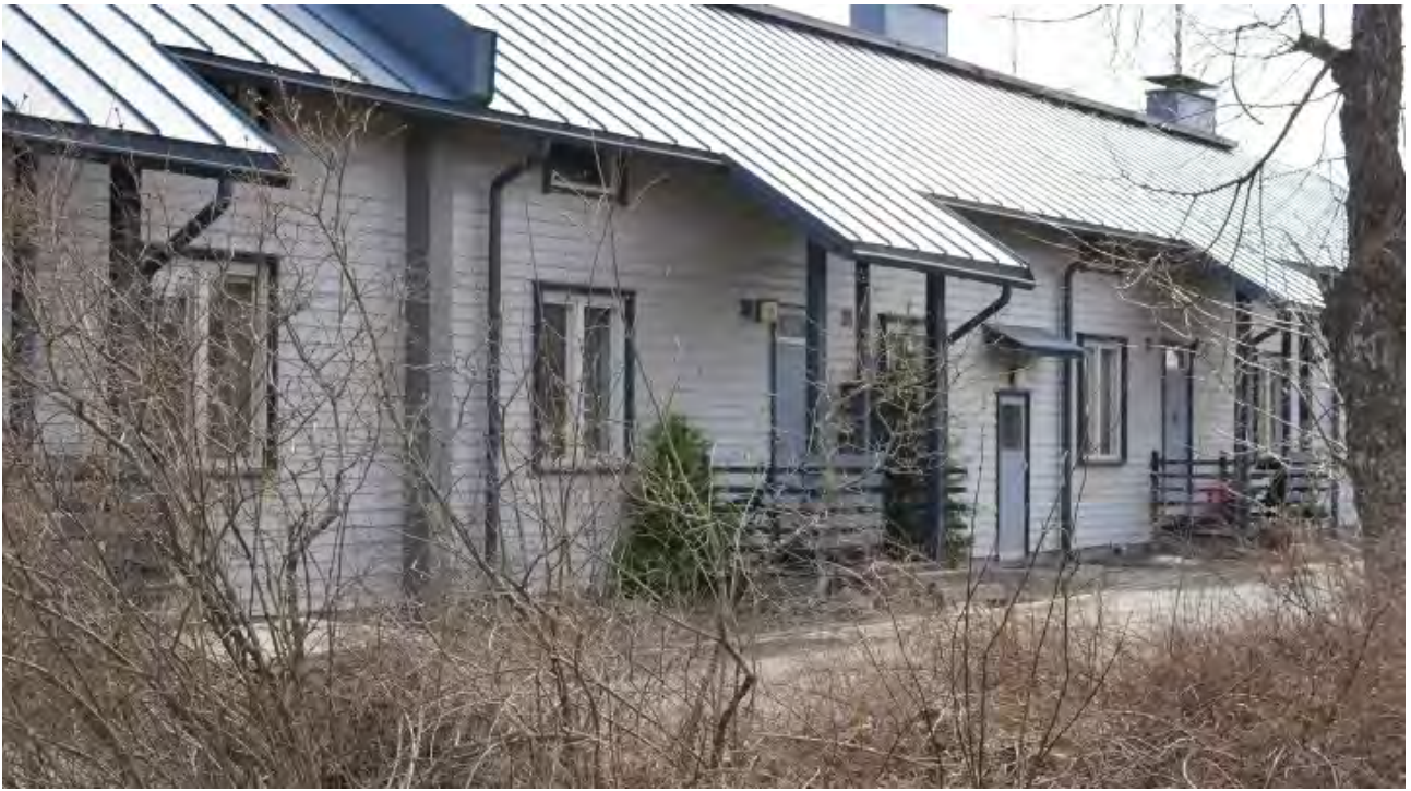
Rakennuksen julkisivua Pajakadun suunnasta.
