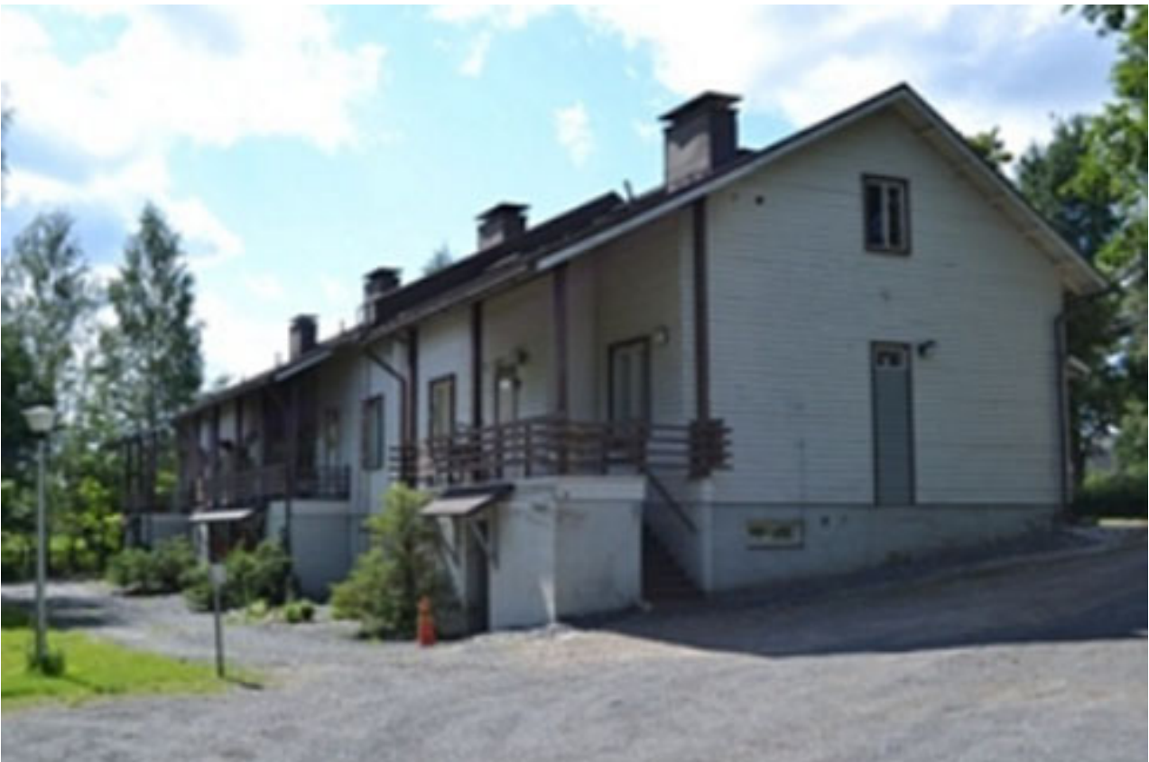
Kuva 12. Pajakadun rivitalon julkisivua pihan puolelta (kuva rakennusinventointi).
