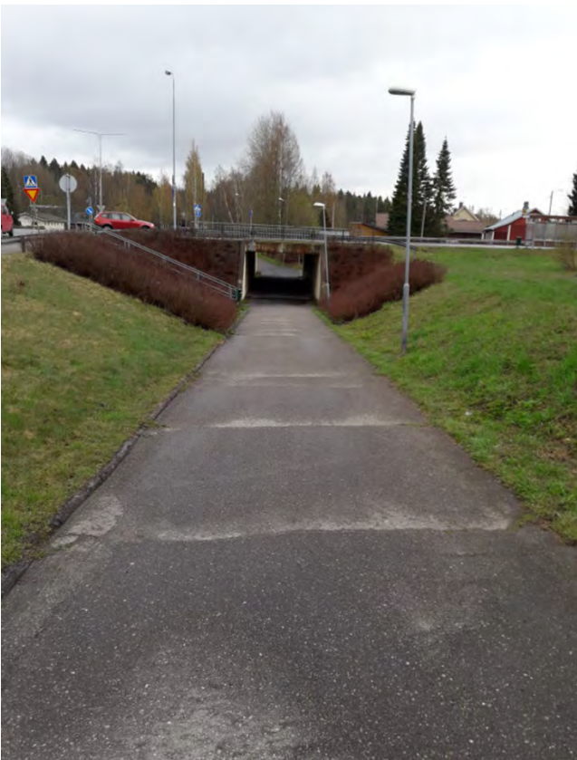
Juvantien alikulku, kuvattuna Peitsarinkujalta.
