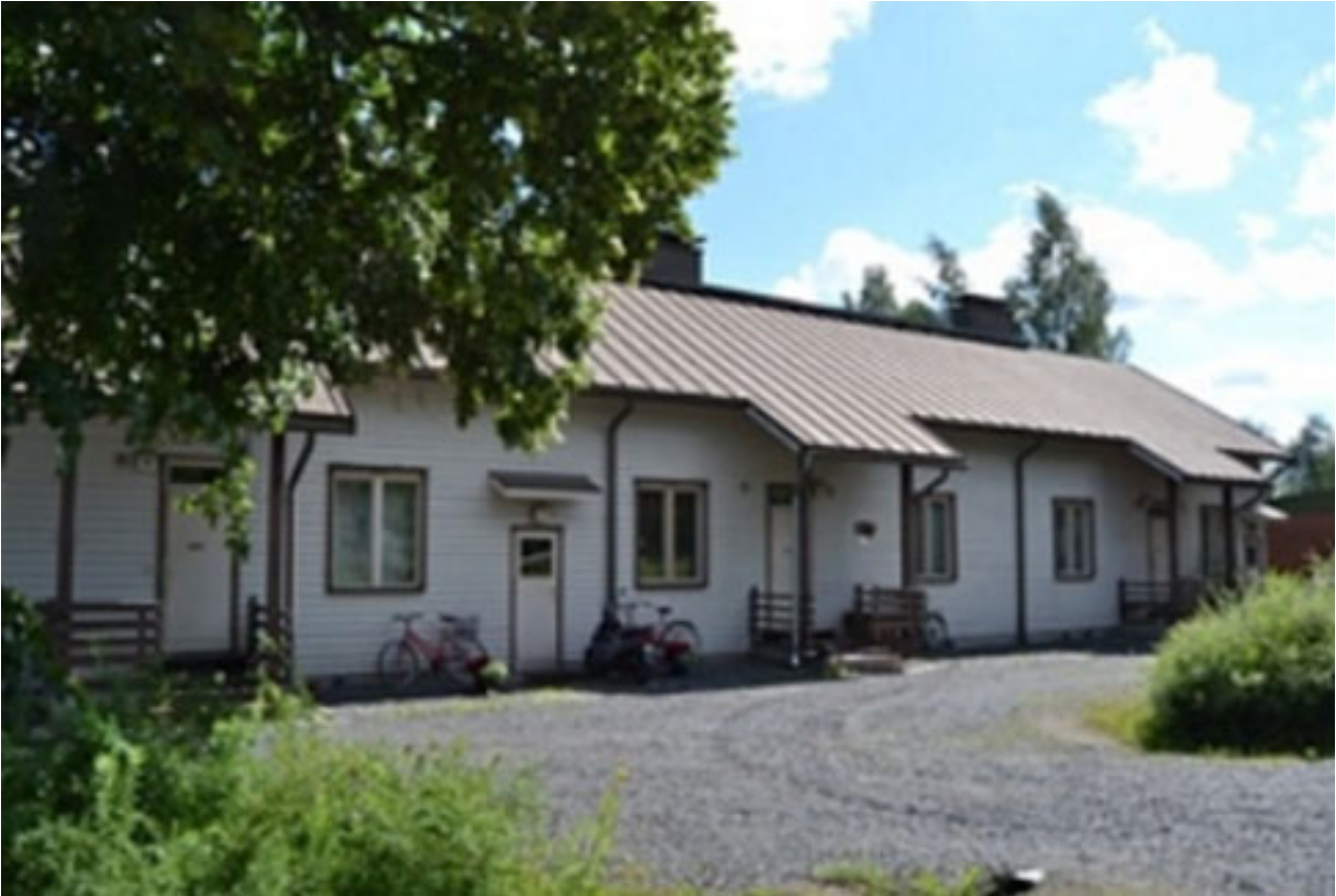
Kuva 11. Pajakadun päässä sijaitsevan rivitalon julkisivua kadun puolelta (kuva rakennusinventointi).
